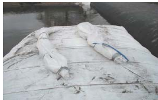
(d) Discharge Hoses Taped to Fill Tubes
