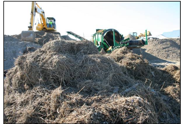
(d) Waste Material Screened from Fill
