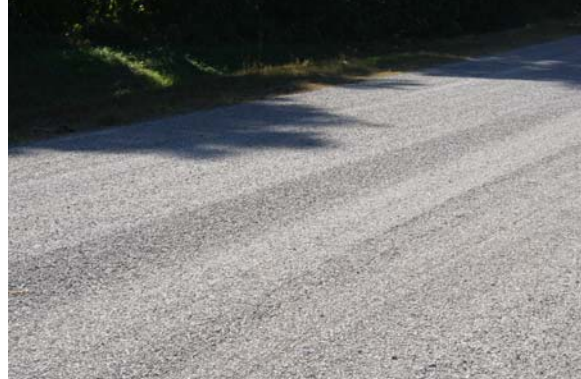
(d) Chip or Scrub Seal Completed-Hwy 17
